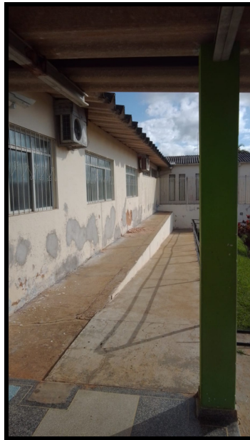
Fachada do CECAES, antes.
