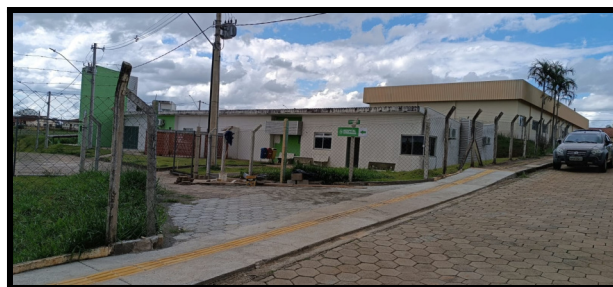
Novo acesso ao hospital veterinário de pequenos animais.
