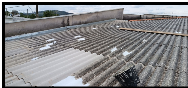
Pessoal da CGIS realizando reparos em telhados.
