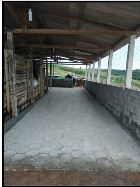
Calçamento e fechamento do setor de compostagem de carcaças.
