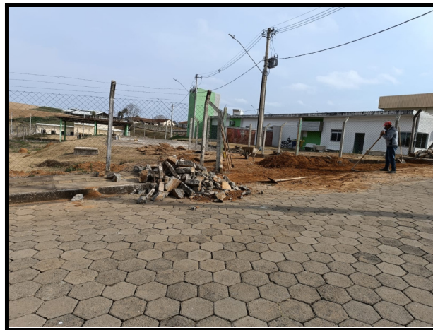
Novo acesso ao hospital veterinário de pequenos animais.
