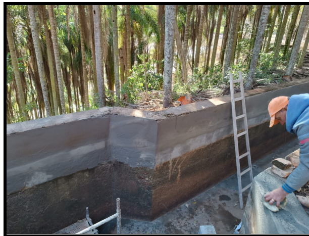
Manutenção e impermeabilização de trechos do canal da usina.
