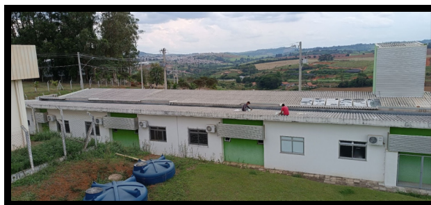
Pessoal da CGIS realizando reparos em telhados.
