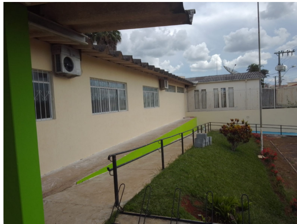
Fachada do CECAES, depois.
