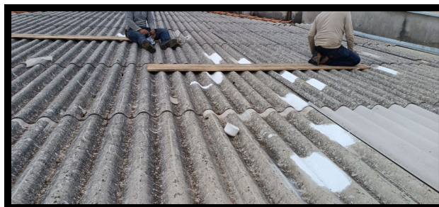
Pessoal da CGIS realizando reparos em telhados.
