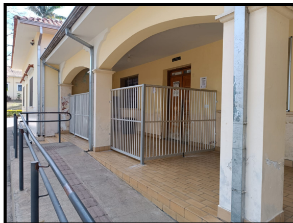
Instalação de grades para evitar que animais entrem no refeitório.
