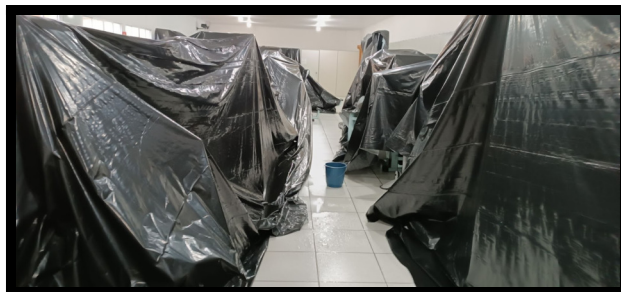
Proteção paliativa para evitar maiores danos.
