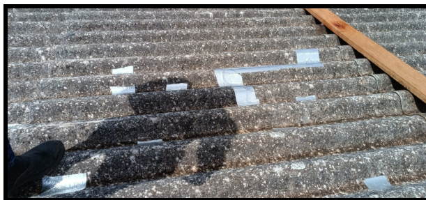
Pessoal da CGIS realizando reparos em telhados.
