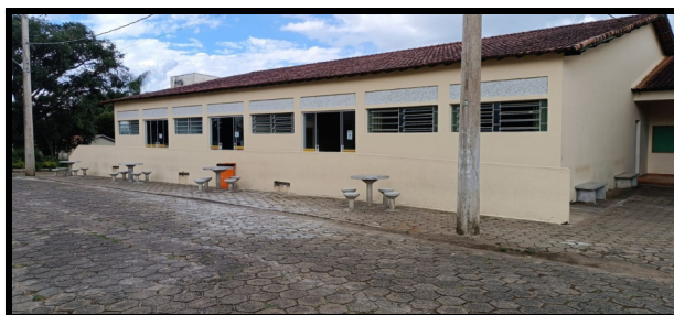
Assentamento de bancos, lixeiras e mesas em diversos locais dentro do Campus.
