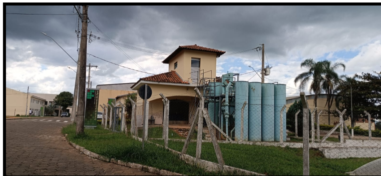
ESTAÇÃO DE TRATAMENTO DE ÁGUA DO CAMPUS.
