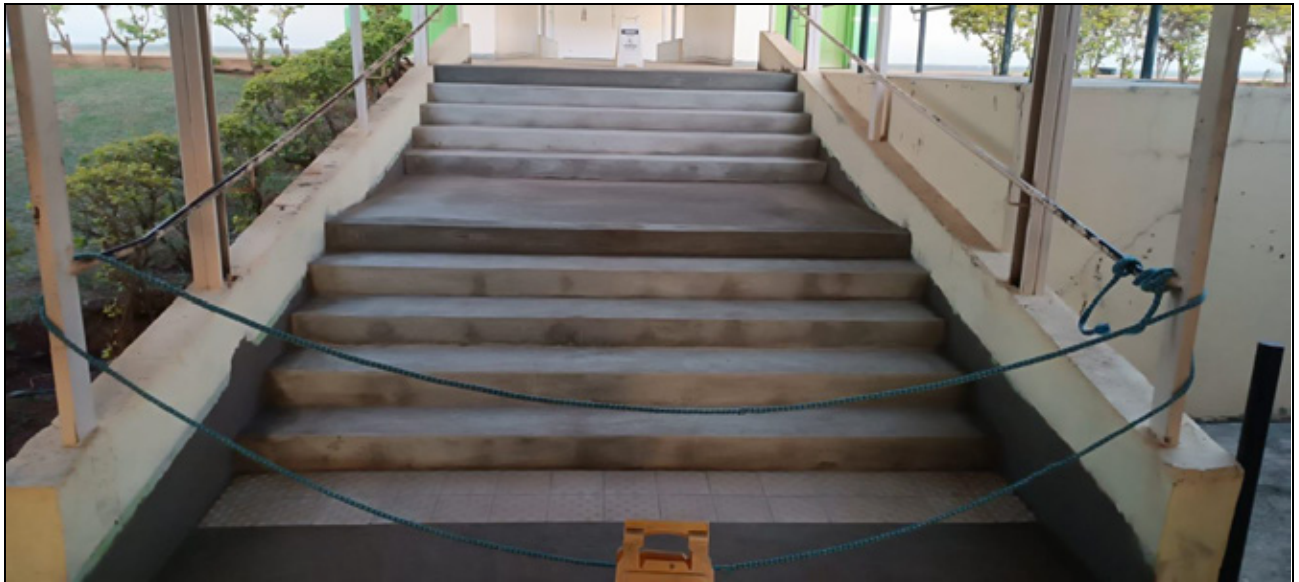
Construção de escada no CeCAES
