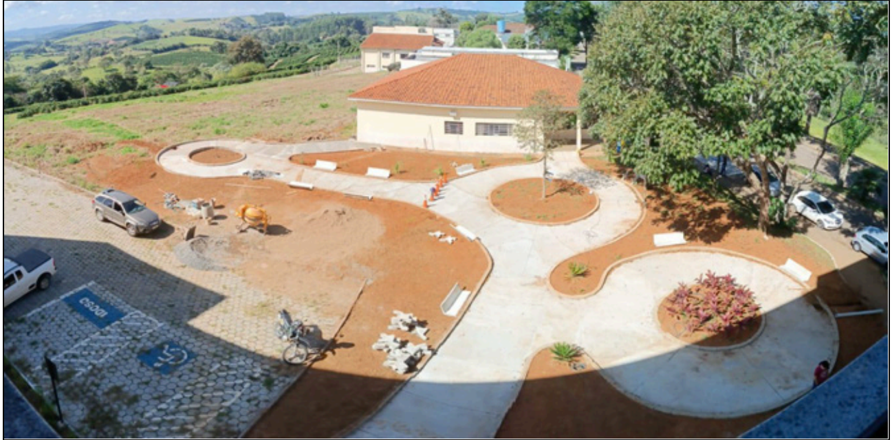
Construção de praça de convivência estudantil
