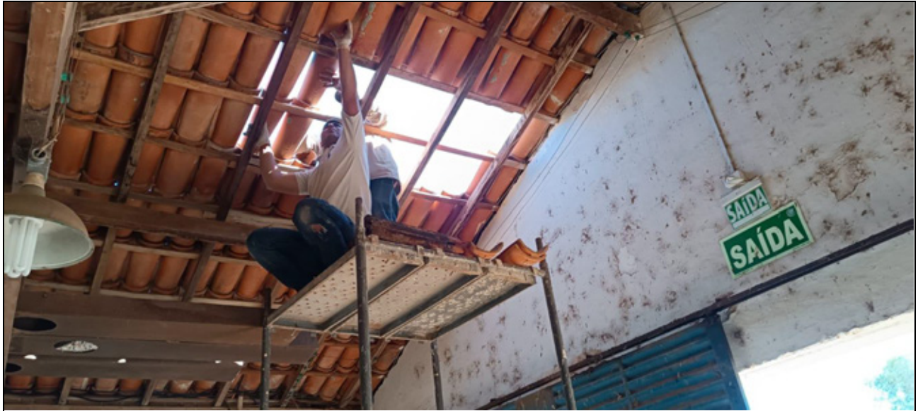
Manutenção em telhado na Fazenda Experimental de Guaxupé
