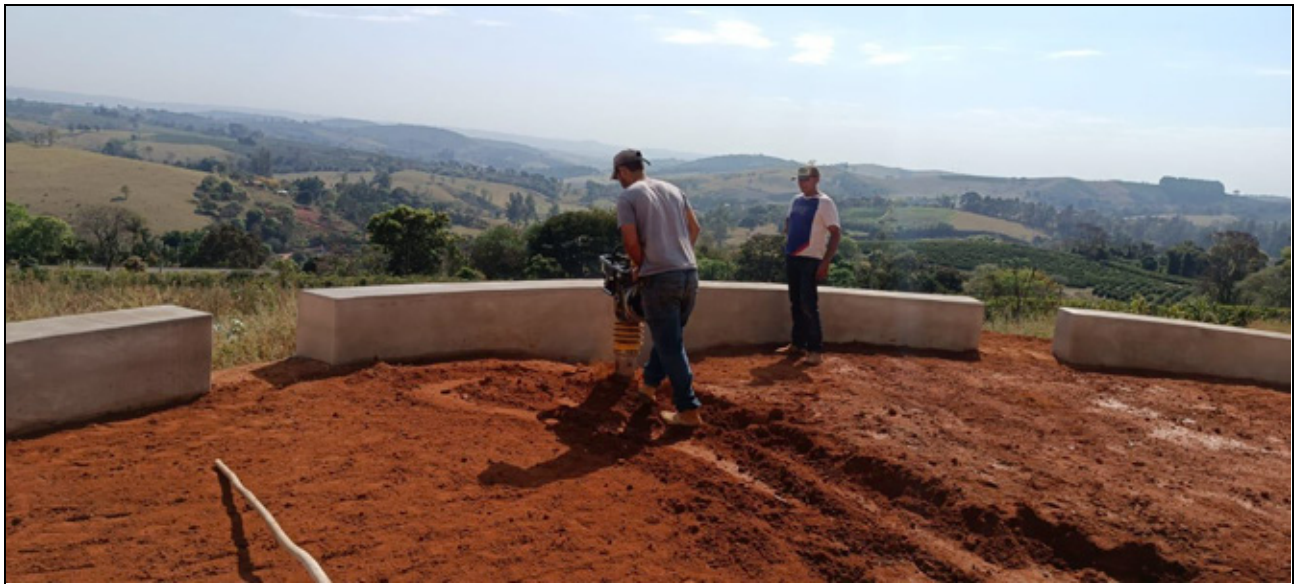
Construção do mirante
