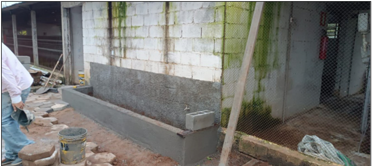
Construção de lava botas no setor de avicultura
