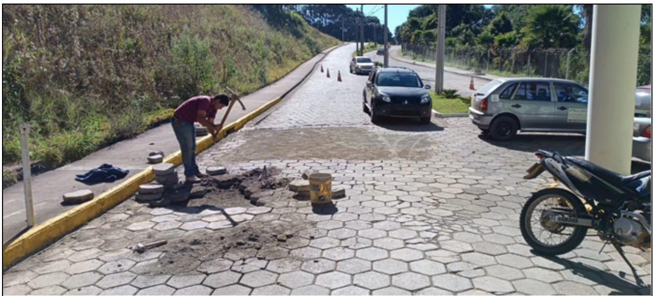
Manutenção de vias
