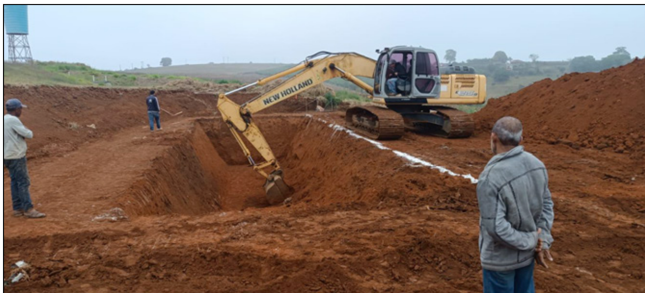
Construção do sistema de captação de água do Free Stall
