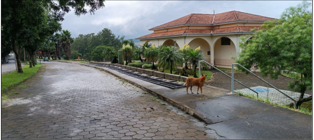
Instalação de grade na frente da Biblioteca
