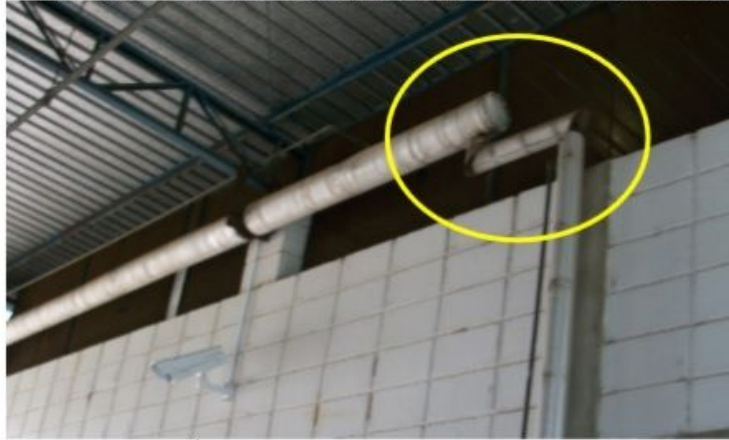
TELAS MILIMÉTRICAS A SEREM SUBSTITUIDAS POR ALVENARIA.
